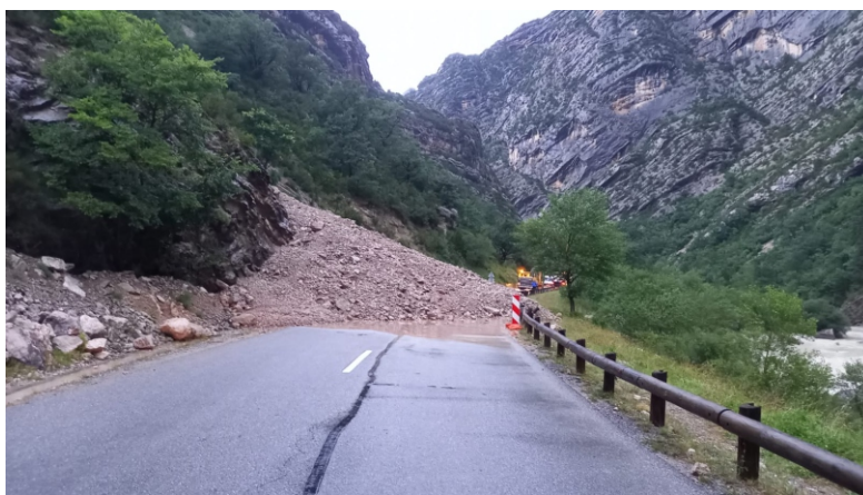
Éboulement sur la RD 952 en juillet 2021 © Mairie de La Palud-sur-Verdon
